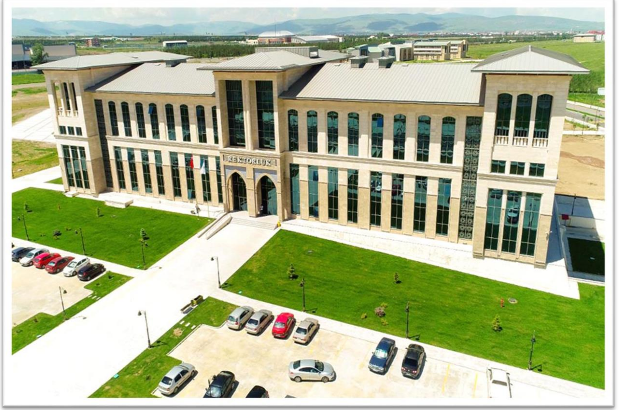
Resim 1: Rektörlük Binasından Görünüm
