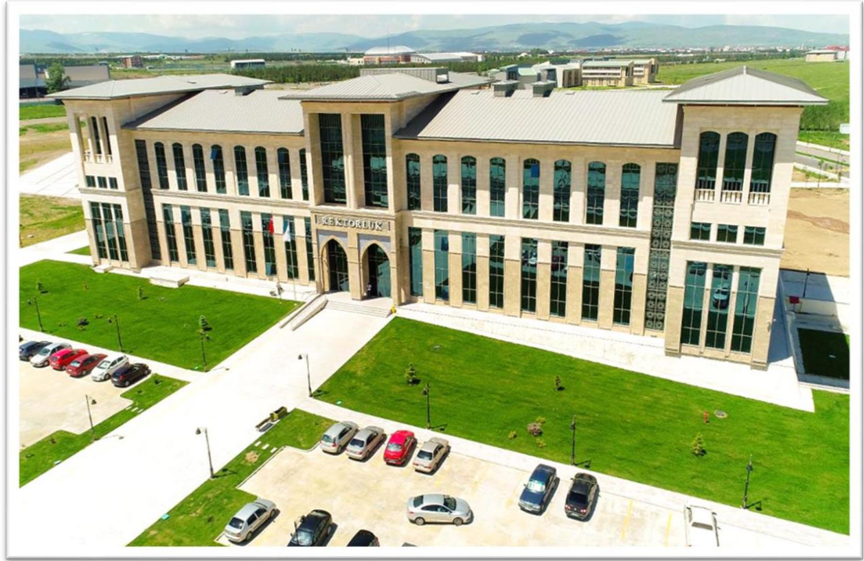
Resim 1: Rektörlük Binasından Görünüm
