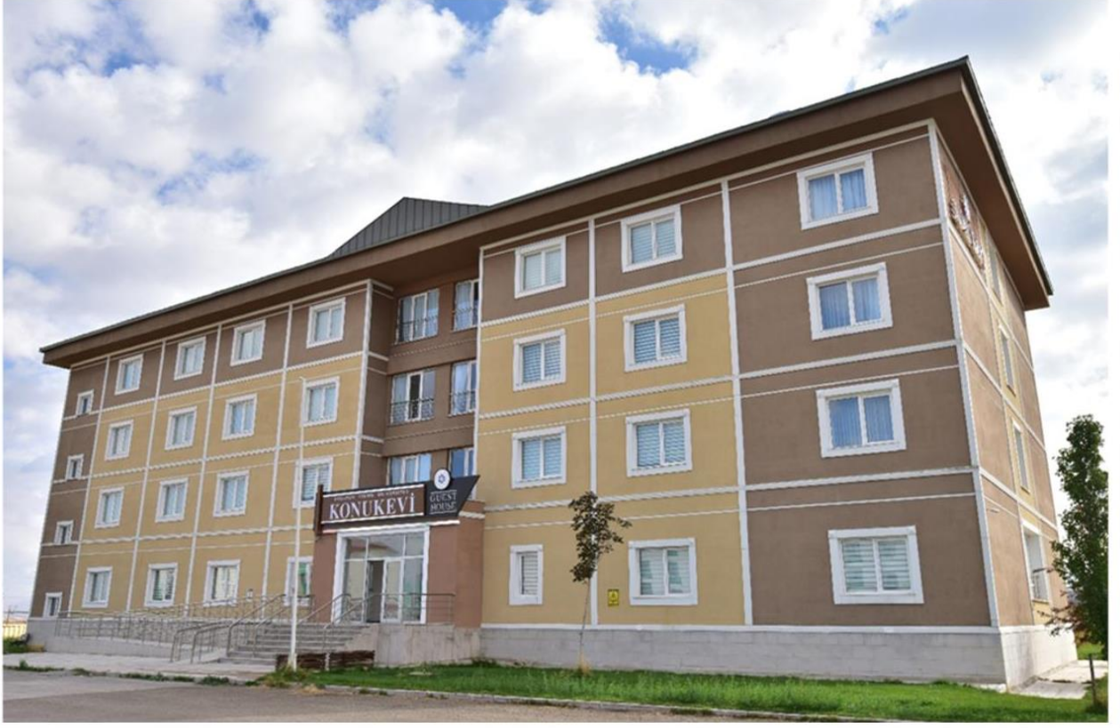
Resim 12: Konukevi Binasından İç ve Dış Görünüm
