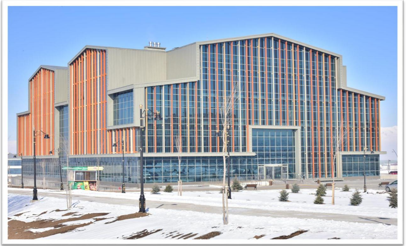
Resim 5: Merkez Kütüphane Binasından Görünüm
